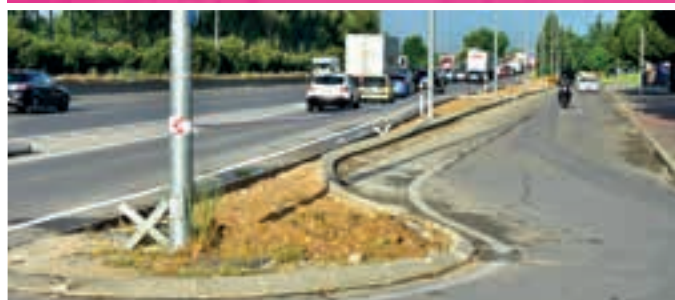
Sustitución del vallado deteriorado del recinto
