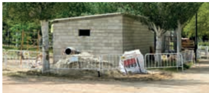
Construcción de nuevos aseos públicos en la zona del lago
