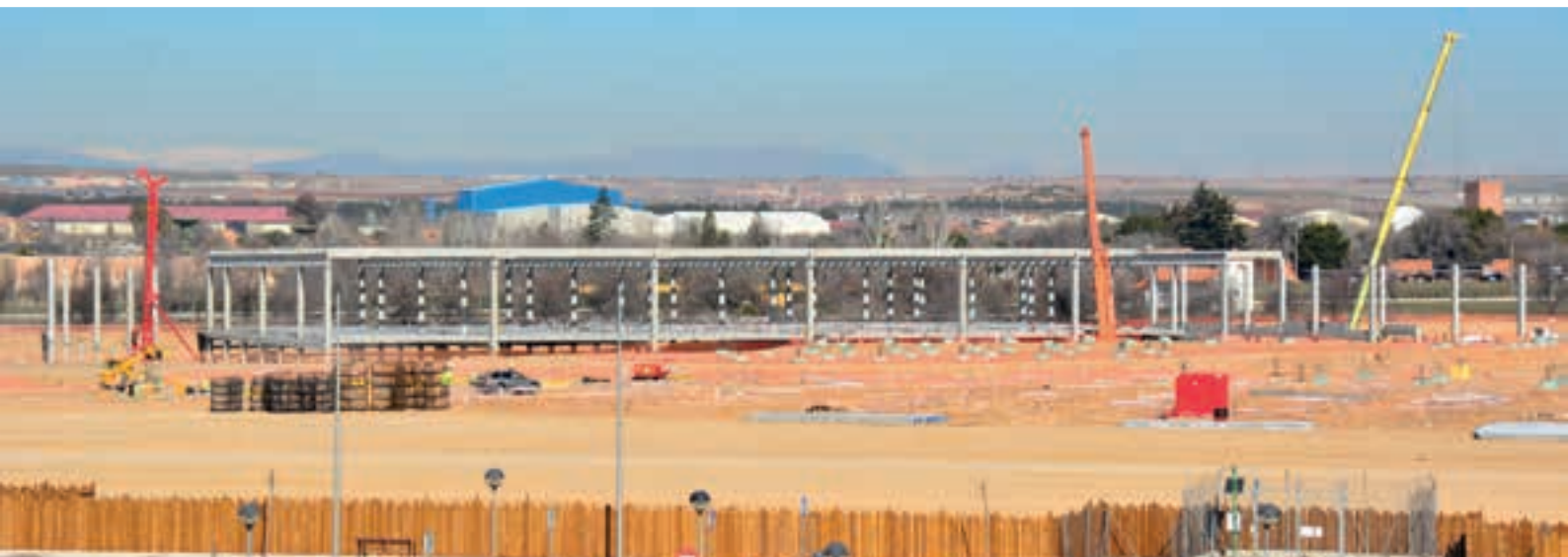
Obras de construcción de Open Sky
