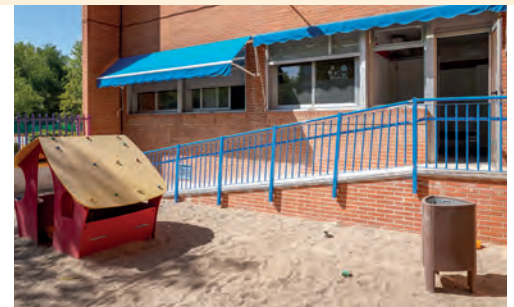
Nueva rampa construida en el colegio Ramón y Cajal
