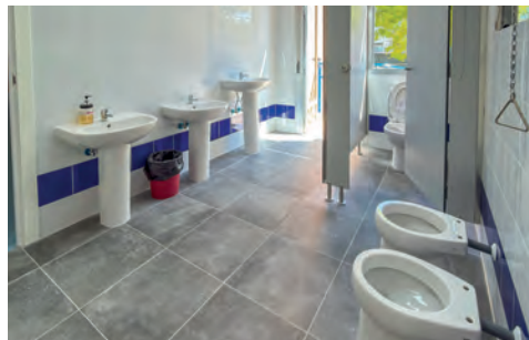
Las inversiones llegan en diferentes aspectos, como la reforma o construcción de aseos
