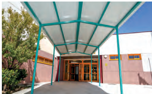
Nueva pérgola en el Colegio de Educación Especial Iker Casillas
