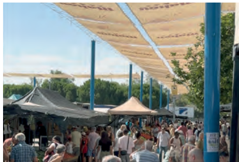
Toldos instalados en el Recinto Ferial antes de las Fiestas Populares que permiten disminuir la temperatura
