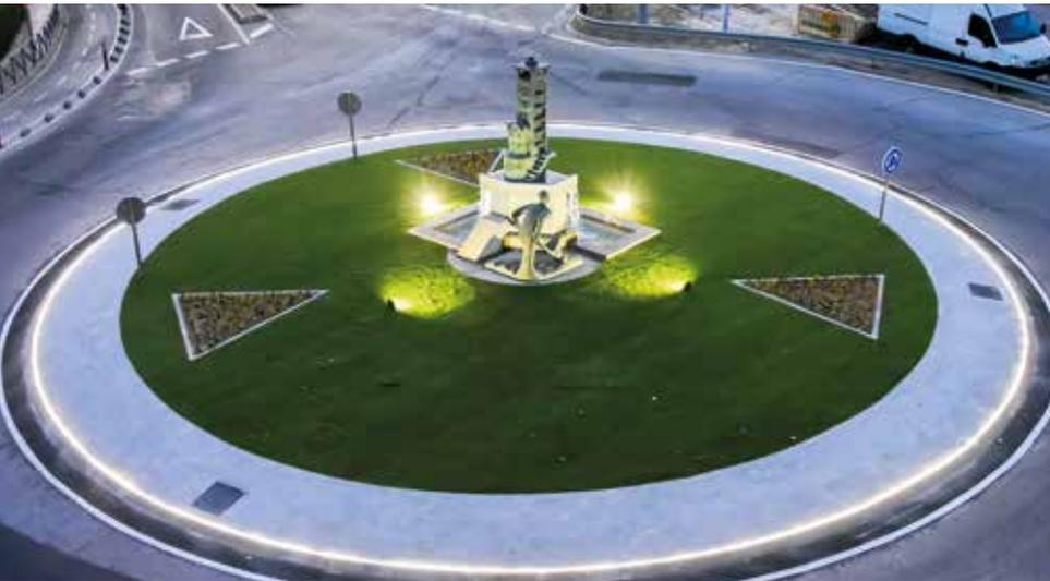
Se ha instalado un sistema de iluminación perimetral con luces tipo LED que mejora la seguridad vial al incrementar su visibilidad de noche
