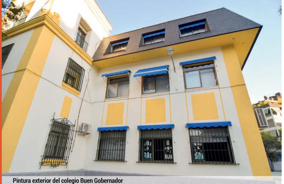
Pintura exterior del colegio Buen Gobernador
