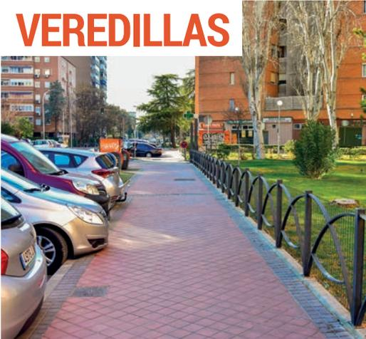
Se ha actuado principalmente en los residenciales Veredillas y Veredillas 2, remodelando 900 m<sup>2</sup> de acerado con baldosa hidráulica antideslizante
