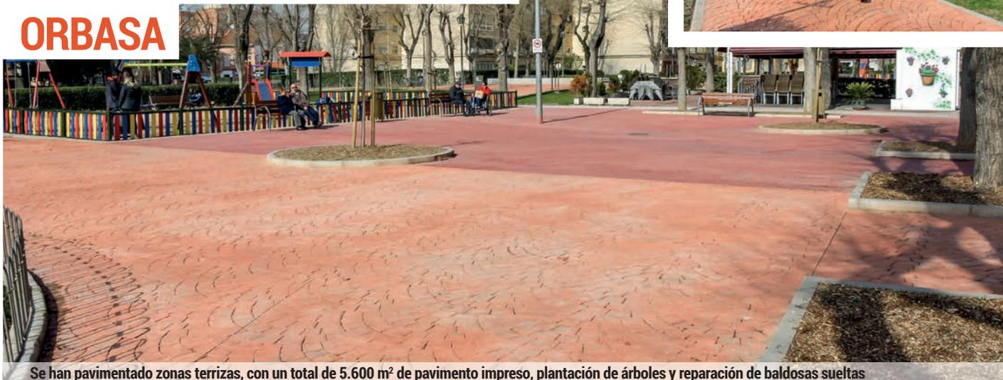
Se han pavimentado zonas terrazas, con un total de 5.600 m<sup>2</sup> de pavimento impreso, plantación de árboles y reparación de baldosas sueltas
