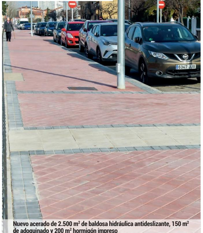
Nuevo acerado de 2.500 m<sup>2</sup> de baldosa hidráulica antideslizante, 150 m<sup>2</sup> de adoquinado y 200 m<sup>2</sup> hormigón impreso
