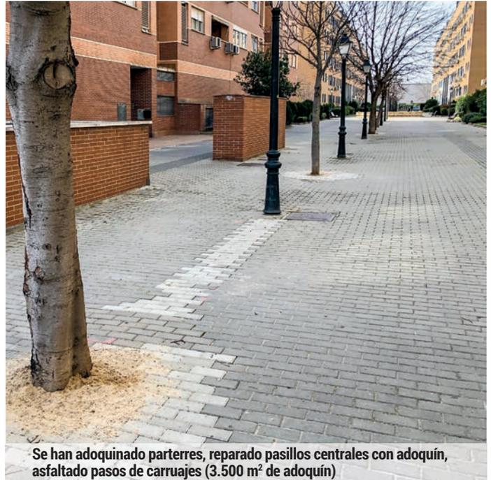
Se han adoquinado parterres, reparado pasillos centrales con adoquín, asfaltado pasos de carruajes (3.500 m<sup>2</sup> de adoquín)
