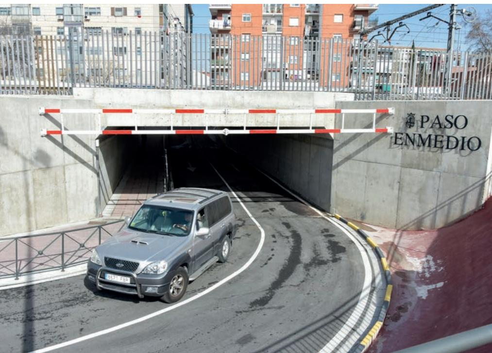
**E**l nuevo túnel al final de calle de Enmedio **cuenta con 2 carriles, uno por cada sentido de 3,15 metros de anchura**, una acera peatonal de 2,7 metros (en total 9 metros de ancho) y una altura de 3,5 metros. En cambio, **el paso inferior que ya existía bajo las vías del tren tenía unas dimensiones reducidas**, 3 metros de anchura total y 1,75 metros de altura, con un único carril para ambos sentidos de 2,50 metros
