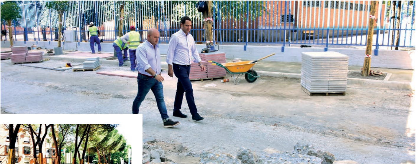
El alcalde y el concejal de Obras visitaron el desarrollo de las reformas en Ronda del Poniente
