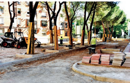
Realización de los trabajos en calle Quintanilla
