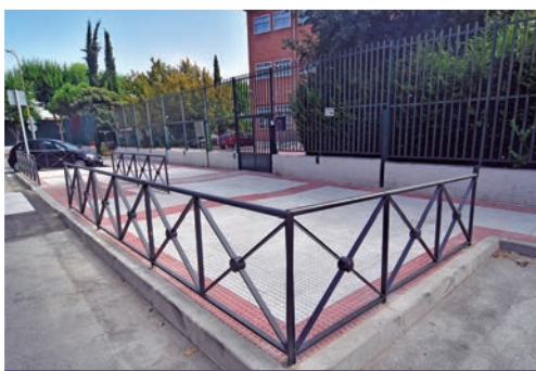
Ampliación de la acera de la puerta principal
