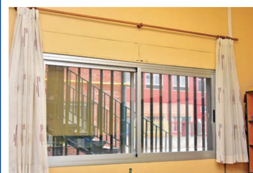
Sustitución de 30 ventanas
