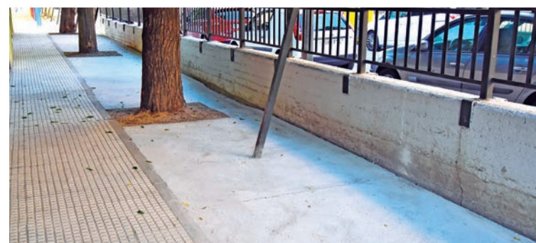
Pavimentación de zonas terrizas
