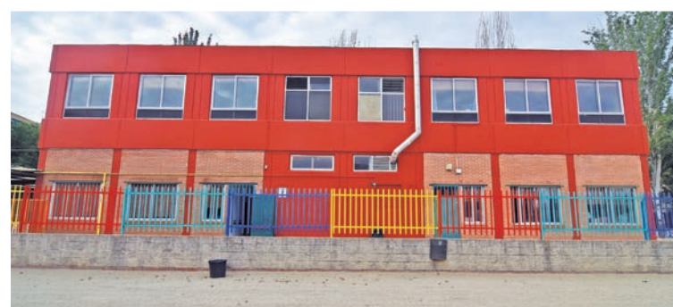
Pintura de la fachada del edificio de Educación Infantil
