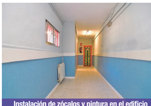
Instalación de zócalos y pintura en el edificio de Educación Infantil
