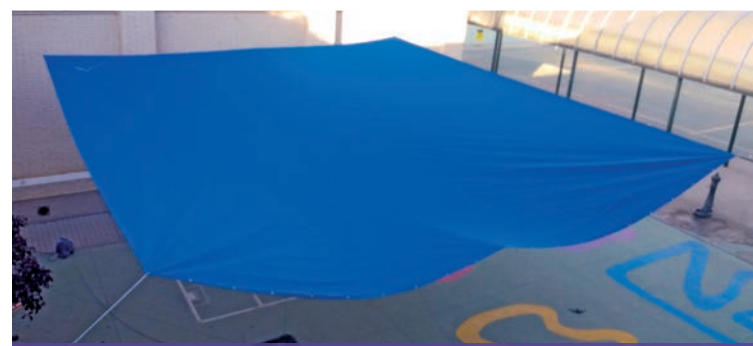
Instalación de cubierta de lona
