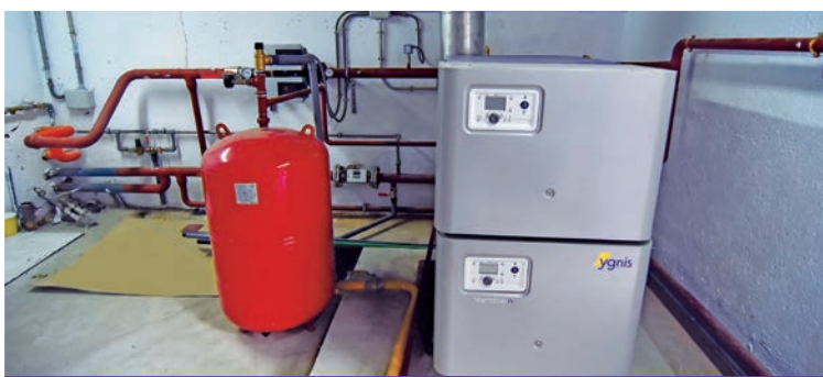
Instalación de nueva caldera para calefacción y agua
