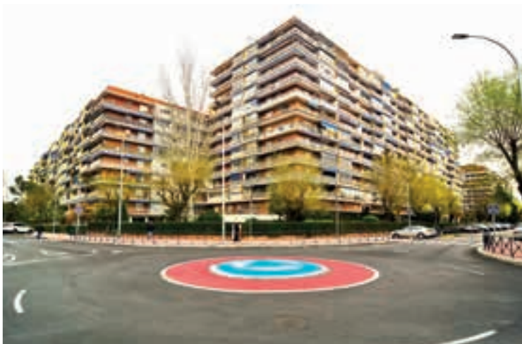
C/ Silicio con C/ Pozo de las Nieves. Rotonda de 4 metros de diámetro
