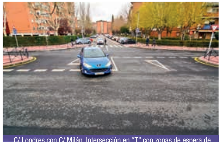
C/ Londres con C/ Milán. Intersección en “T” con zonas de espera de giro a la izquierda entre las medianas
