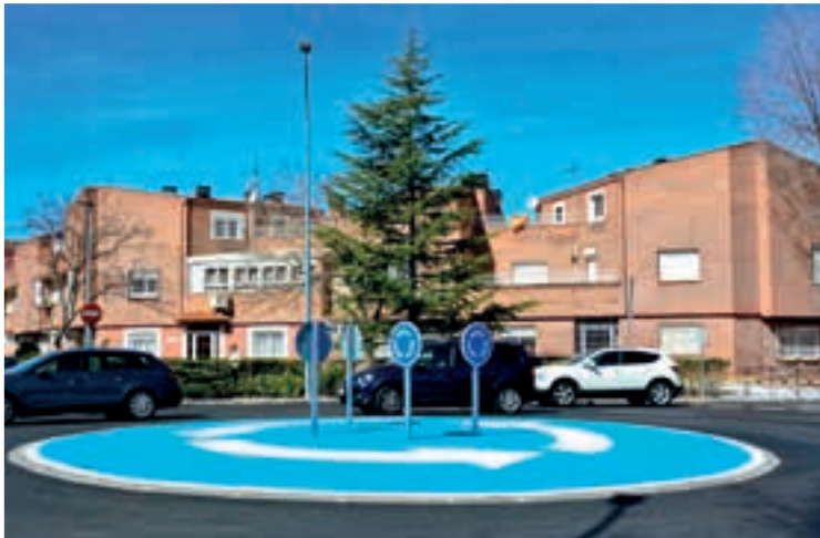
C/ Circunvalación con C/ Plata. Rotonda de 10 metros de diámetro
