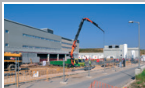
Inicio de las obras
