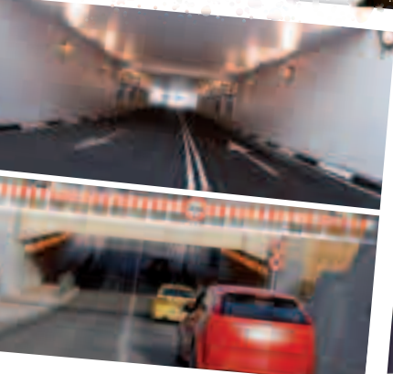
Paso de Loeches Paso de Zapatería
