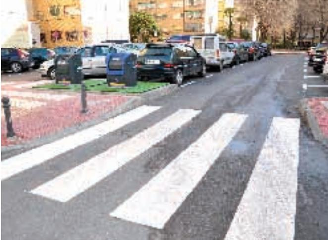
Las obras de reforma han consistido en la renovación del acerado y el asfaltado, la eliminación de numerosas barreras arquitectónicas, la regulación de los aparcamientos, con la creación de seis plazas reservadas para personas con discapacidad, la reordenación del tráfico, la instalación de nuevo mobiliario urbano y de baldosas que facilitan la orientación de las personas con algún tipo de discapacidad visual.
