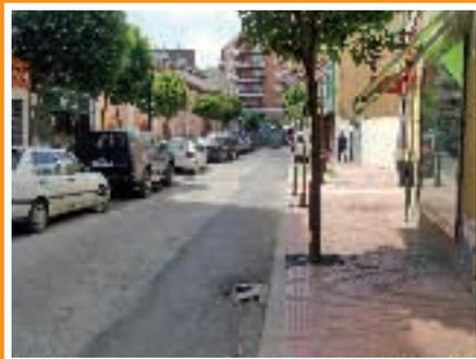
existente en la calle, ya que el anterior estaba muy deteriorado, colocándose 570 metros lineales de bordillo, 1.150 metros cuadrados de adoquín para la calzada y 1.700 de baldosa granallada roja y gris.
