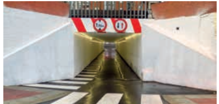
Mejora túnel subterráneo bajo vías tren
