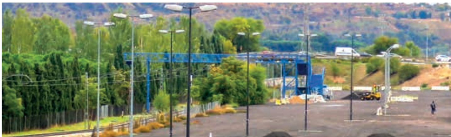
Nuevo gran aparcamiento provisional con 2.000 plazas: iluminación y compactación
