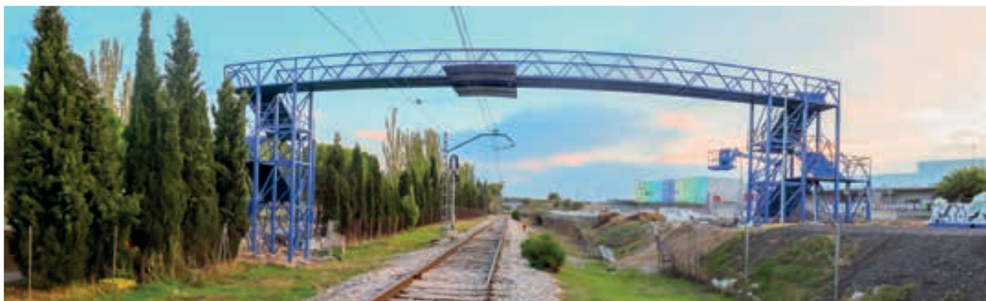
Dos nuevas pasarelas para unir la Estación de Tren de Torrejón y el Recinto Ferial con el nuevo gran aparcamiento provisional
